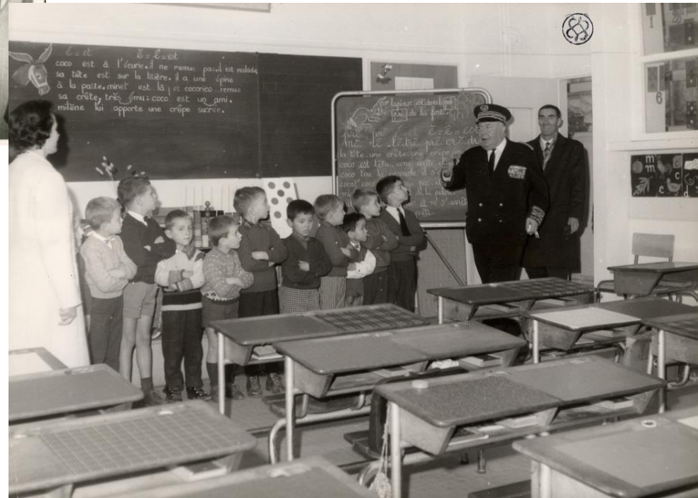
Salle de classe lors de l'inauguration de l'école rue Saint-Louis, 6 novembre 1965.
